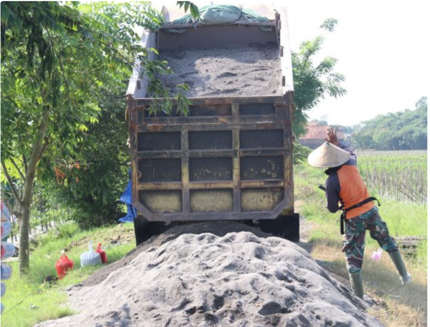
( Foto istimewa ) material pengecoran jalan usaha tani terus dipasok
