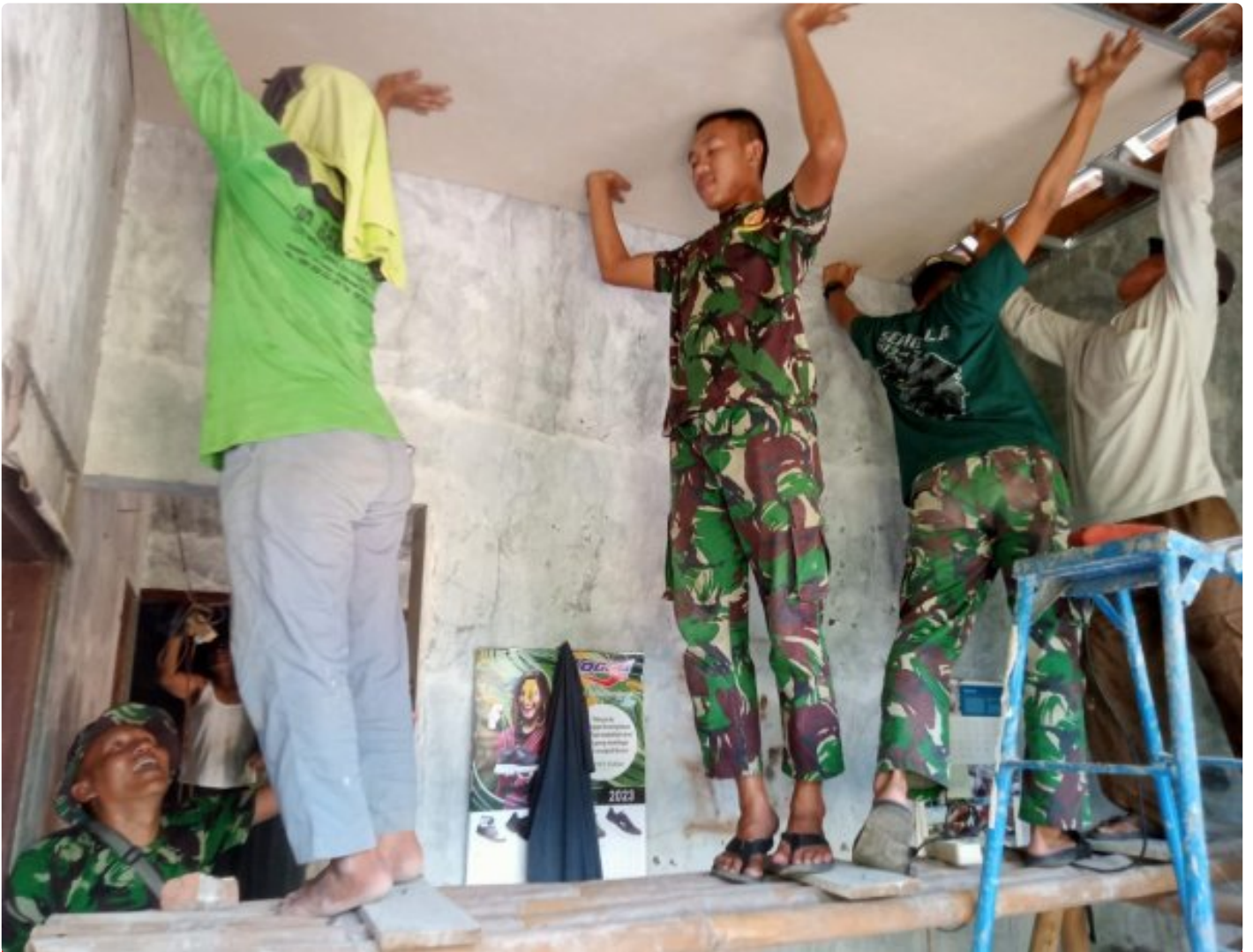
(Foto Istimewa) Pemasangan Plafon RTLH TMMD 116 Kodim 0722/Kudus
