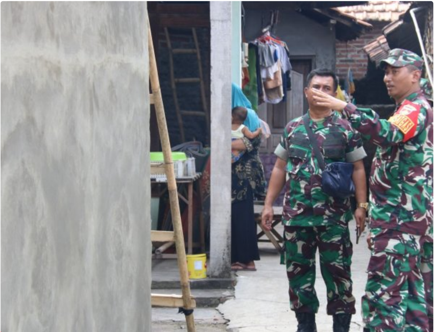
(Foto istimewa ) dansargas tmmd tinjau lokasi RTLH
